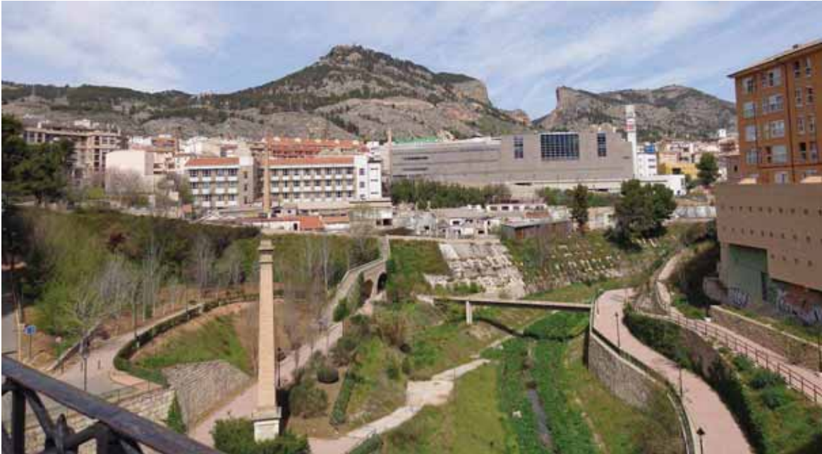
Vista del cauce desde el puente de María Cristina
